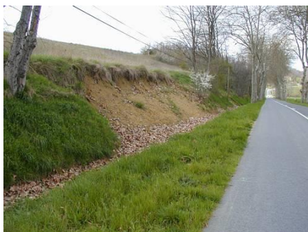
Figure 66 : Glissement de terrain le long de la RD83 à Castres (source : Géorisques)
