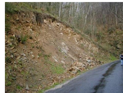
Figure 69 : Eboulement à Mazamet (source : Géorisques)
