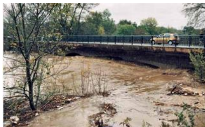
Figure 61 : Le Thoré sous le pont RD85 en 1999 (source : DCS de Castres)
