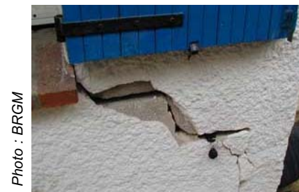
Manifestation des dégâts
