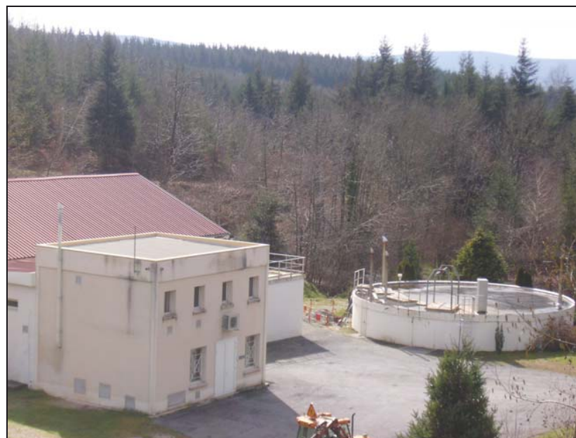
Usine de traitement d'eau potable
