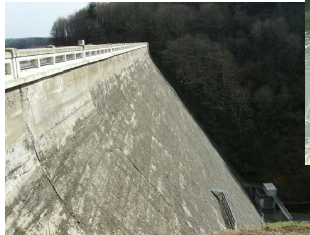
Barrage des Saint-Peyres
