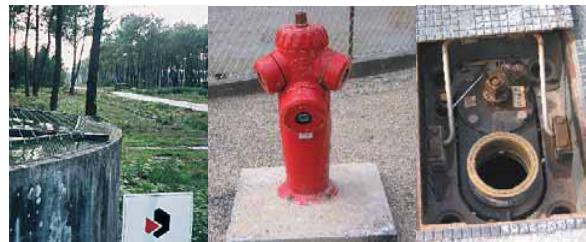
Réserve artificielle en bordure de piste Poteau d'incendie Bouche d'incendie
