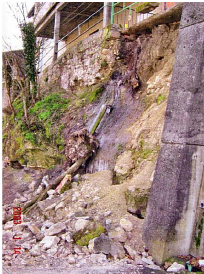
Berges de Saïx : glissement de terrain
