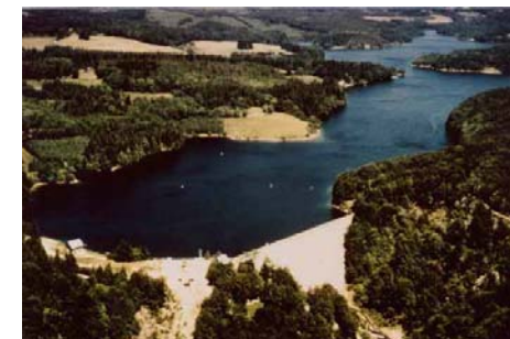
Barrage des Saint-Peyres
