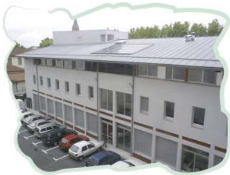
Capteurs photovoltaïque - MCEF Castres
